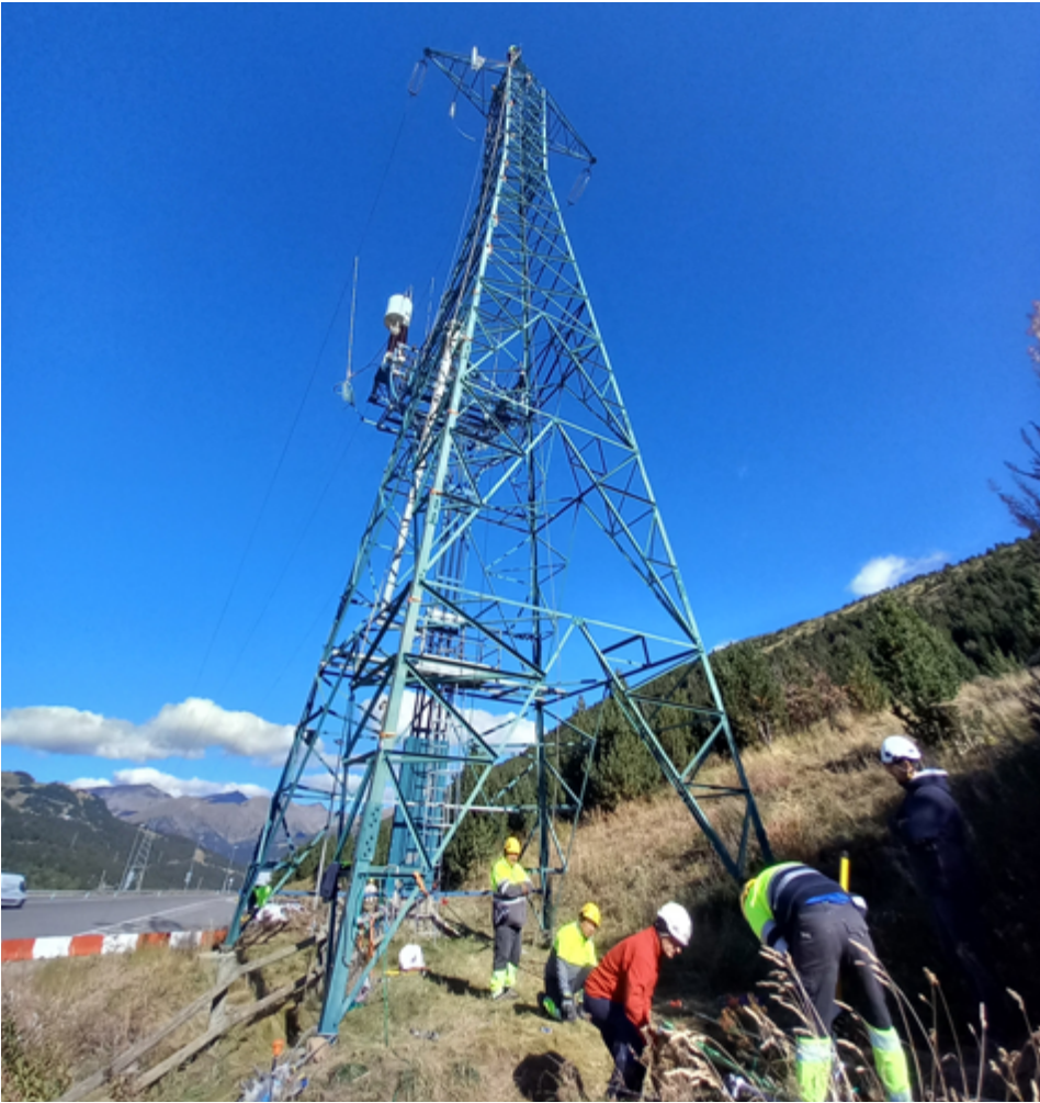
Desmuntatge de l'antiga línia d'alta tensió Encamp - Grau Roig.
